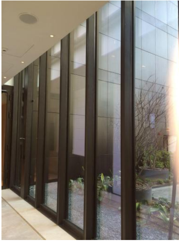
Çelik giydirme cephe kurgusu / Düşey - yatay arakesitlerinin yaş boya ile kaplanması...
