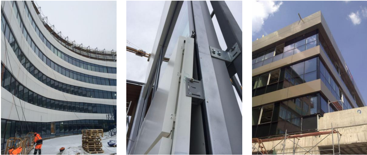
Giydirme Cephe Kurgusu Üzerine Bağlanan Sağır Kaplama Birimleri / Alüminyum Levha Kaplama Uygulama Görüntüleri
