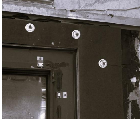
Çevre Yalıtım Hattında Yalıtım Örtüsü Üzerine Yapıştırılan Taşyünü Çivisi / Uygulama Örneği
