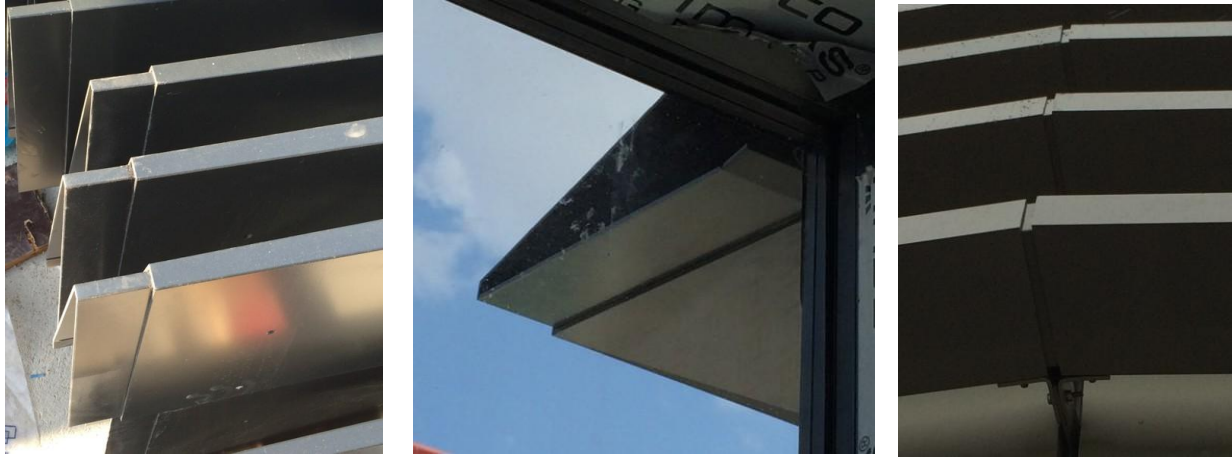
Alüminyum Güneş Kırıcı Bileşeni / Birleşim Ek Yeri Geçme Parçası / Ana Bileşen İle Eş Renkte Kaplanmış / Uygulama Örnekleri
