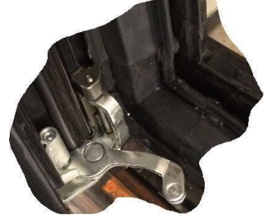
Köşe / Orta Bini Yalıtım Yastığı-Doğrama
