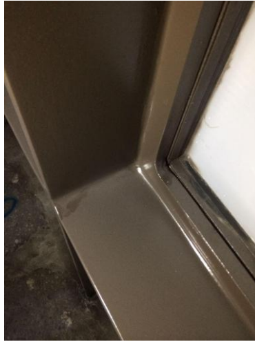
Çelik giydirme cephe kurgusu / Düşey - yatay arakesitlerinin yaş boya ile kaplanması...
