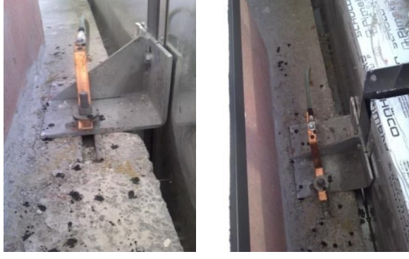
Cephe Topraklanması ile ilgili uygulama görüntüleri
