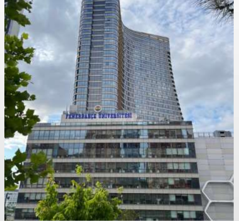
Ataşehir Kampüsü Ek (B) Blok
