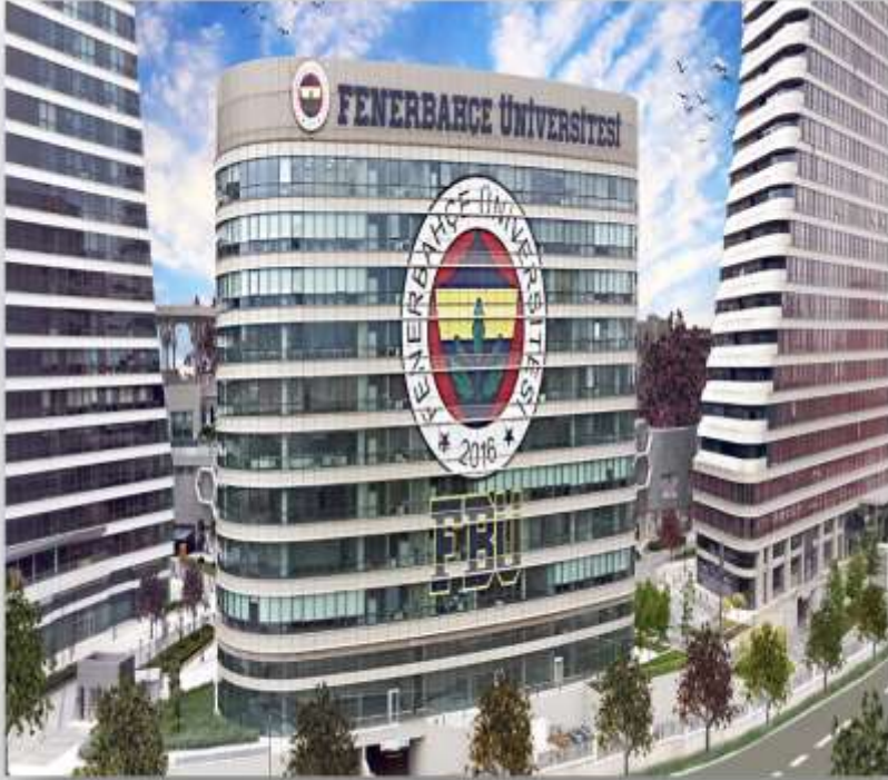
Ataşehir Kampüsü Ana (F) Blok
